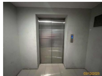
รูปที่ 2-44 ลิฟต์ดับเพลิง
