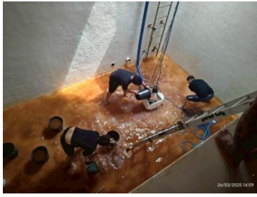
รูปที่ 2-65 ล้างทำความสะอาดถังเก็บน้ำ
