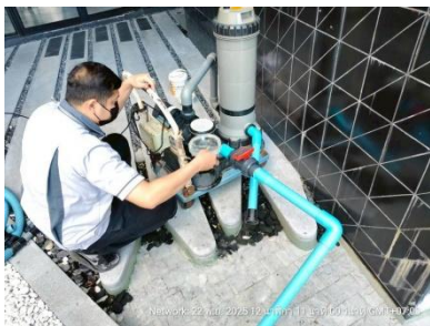
รูปที่ 2-80 ตรวจสอบระบบกรองสระว่ายน้ำ
