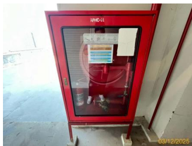
รูปที่ 2-42 ตู้เก็บสายฉีดน้ำดับเพลิงพร้อม อุปกรณ์
