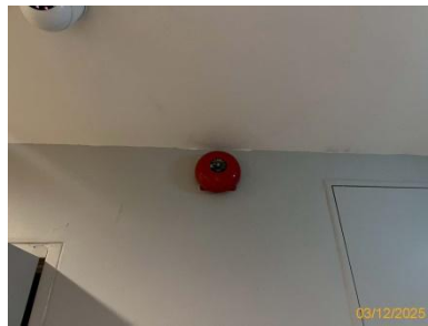
รูปที่ 2-49 สัญญาณกระดิ่งแจ้งเหตุ อัคคีภัย (Alarm Bell)
