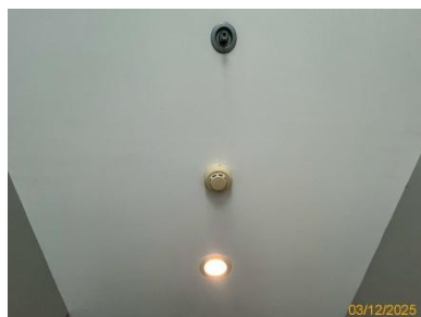
รูปที่ 2-46 เครื่องตรวจจับควัน (Smoke Detector)
