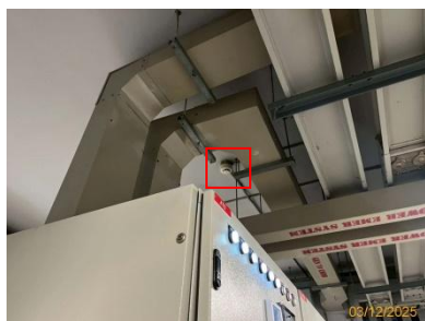
รูปที่ 2-36 เครื่องตรวจจับควัน (Smoke Detector) ภายในห้องเครื่องหม้อแปลง ไฟฟ้า
