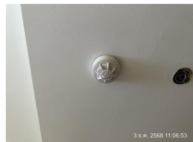
รูปที่ 2-47 เครื่องตรวจจับความร้อน (Heat Detector)
