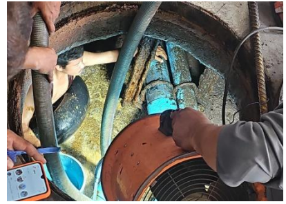
รูปที่ 2-76 ตรวจสอบการสะสมของตะกอนในบ่อกักน้ำภายในโครงการ และท่อระบายน้ำภายในโครงการ
