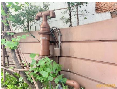
รูปที่ 2-8 บำบัดก๊าซมีเทนโดยรวมผ่านท่อขนาด 3 นิ้ว ต่อดิน
